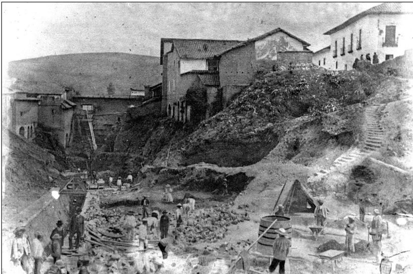
Figura 2.1. Obras de canalización de la quebrada Ullaguangayacu, circa 1904
