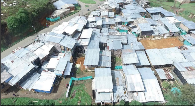
Fotografía 9.1 Invasiones sobre suelo rural (imagen realizada con dron el 4 de agosto de 2018).
