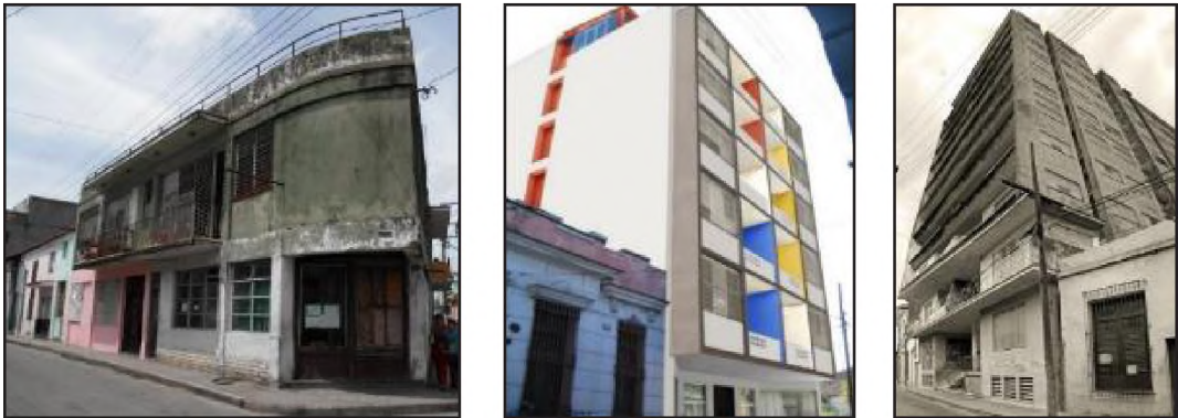
Figura 2. Edificios del Movimiento Moderno de dos, siete y once niveles.
