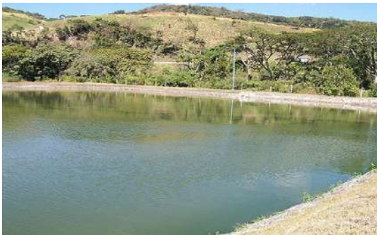
Figura 36. Laguna de maduración.
