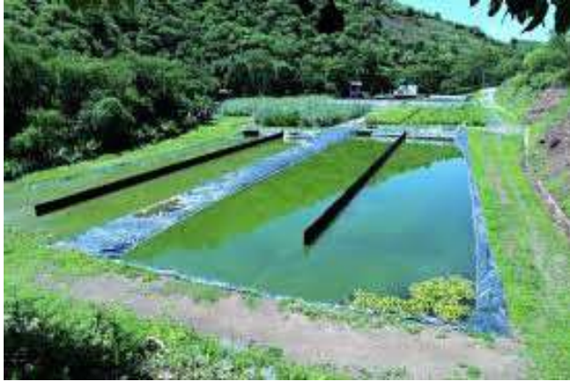
Figura 27. Laguna de maduración.
