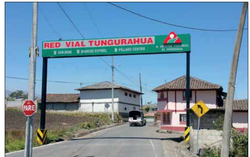
Ruta pavimentada y señalización realizadas por el gobierno provincial.
