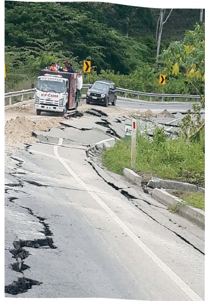
b) Grietas en el suelo
