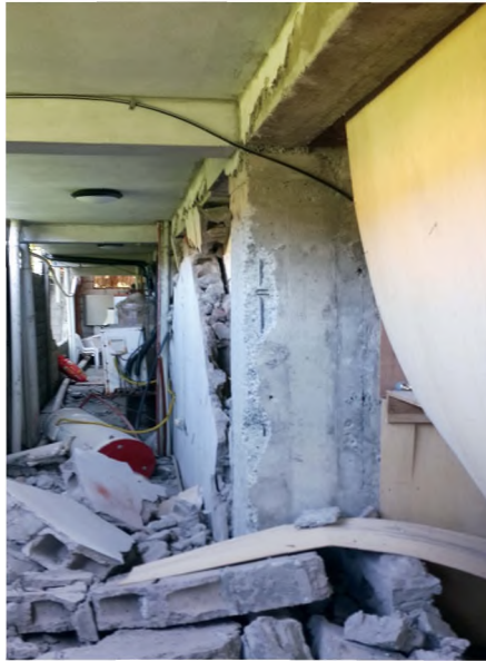
Figura 5.5.35 Tanque de propano fuera de su base. Cercar el área insegura. Canoa, Ecuador 2016.
