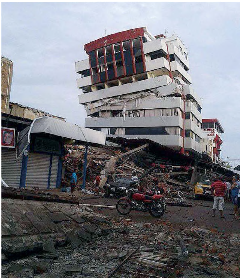
Figura 5.5.9 Colapso total de la estructura. Portoviejo, Ecuador 2016.
