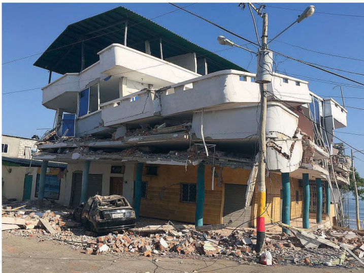
Figura 5.5.5 Colapso total de la estructura. Terremoto de Portoviejo, Ecuador 2016.
