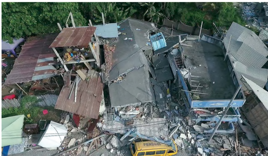
Figura 5.5.13 Colapso total de las estructuras. Terremoto de Pedernales, Ecuador 2016.
