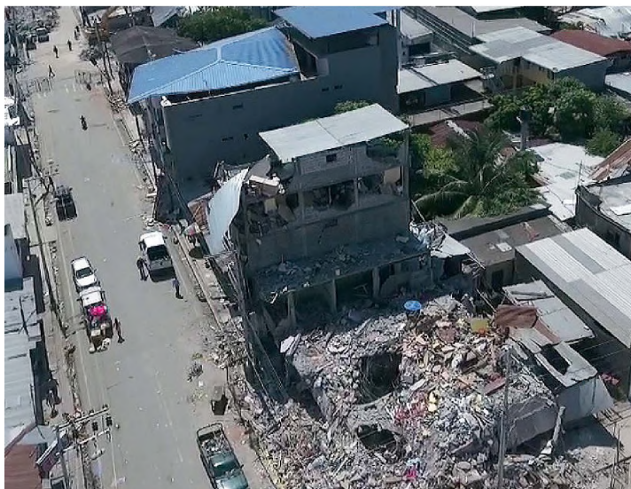
Figura 5.5.6 Colapso total de la estructura. Terremoto de Pedernales, Ecuador 2016.
