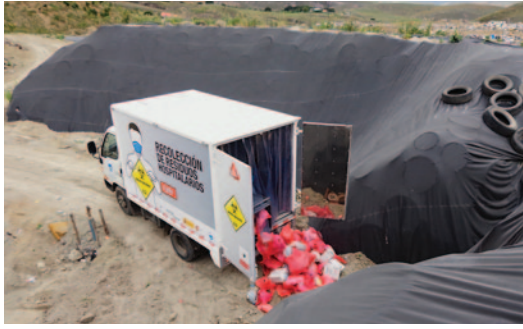
Foto IPADE. Celda de seguridad para desechos hospitalarios.
