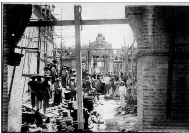
Figura 2. Construcción del Palacio de la Exposición Nacional 19
