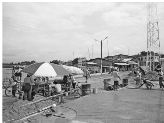
Figura 26. San Lorenzo. Obras de infraestructura y mejoramiento. Agosto 2006
