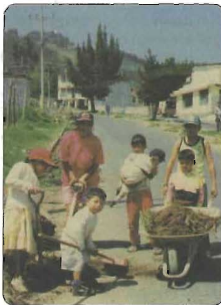
Obras de Mejoramiento Barrial en los Barrios del Noroccidente
