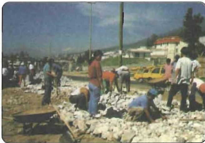
Obras de Mejoramiento Barrial en los Barrios del Noroccidente
