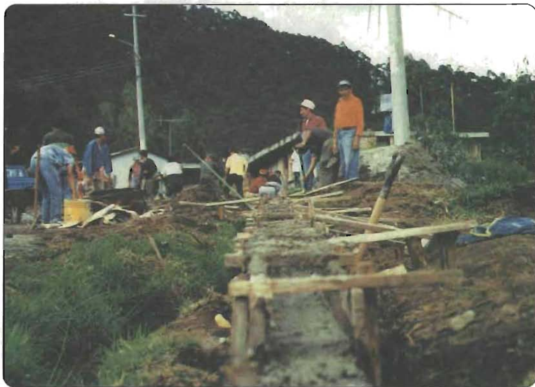
Realización de obras en los barrios
