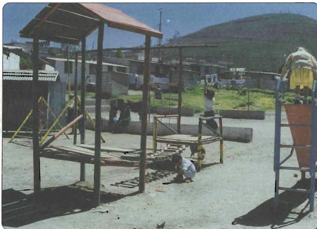
Construcción de un espacio de recreación infantil en la Cooperativa Jaime Roldós Aguilera
