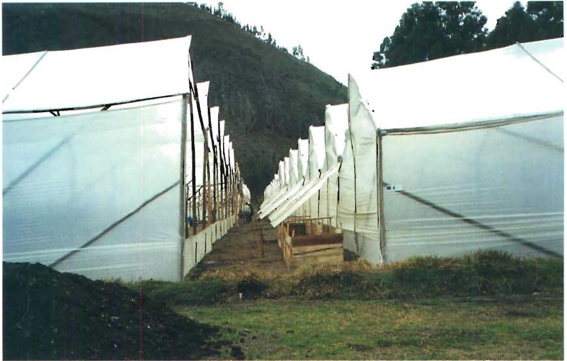
Construcción de invernaderos
