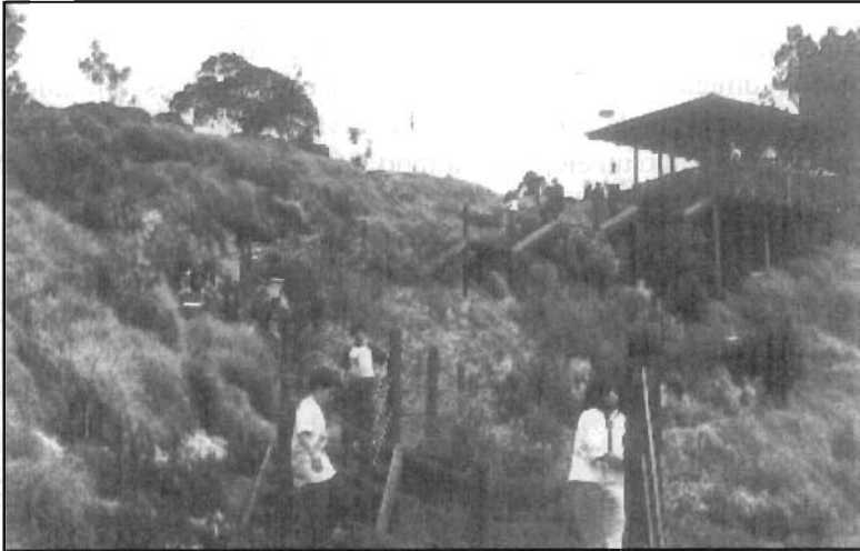
Gradas de acceso al puente colgante, que cruza la quebrada sobre el Río Machángara
