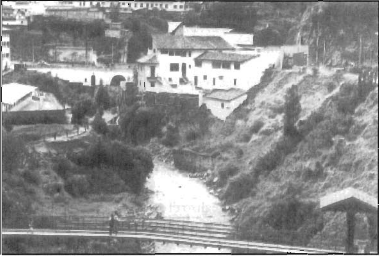
Puente sobre el Río Machángara, parque Lineal
