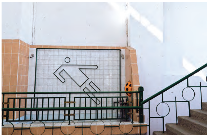
▲ Detalle en el interior del Estadio Reales Tamarindos de Portoviejo, 2012. (FOTO: RICARDO BOHÓRQUEZ)
