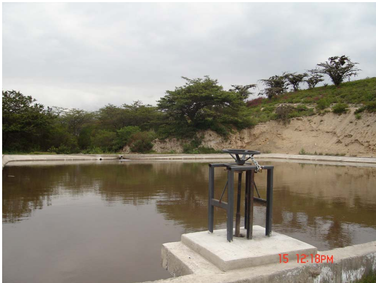
Fotografía N° 24. Reservorio con aguas del Pisque en el Pucará Huayna Capac, para uso de barrios aledaños
