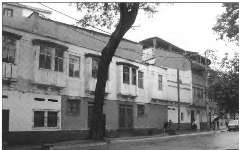
Fotografía 1 Fachada de inquilinato en un inmueble consolidado
