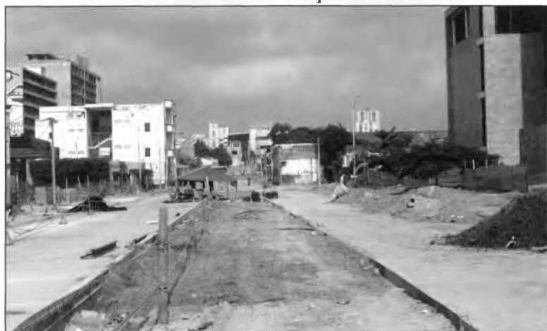
Fotografía 9 Repavimentación Carrera 46. Obras de Transmetro frente al Parque Cultural del Caribe
