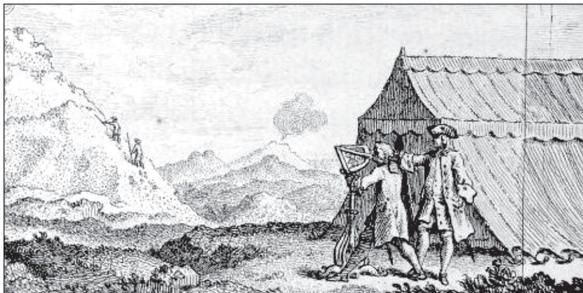
Illustration 1 L'utilisation du quart de cercle pour mesurer les angles
