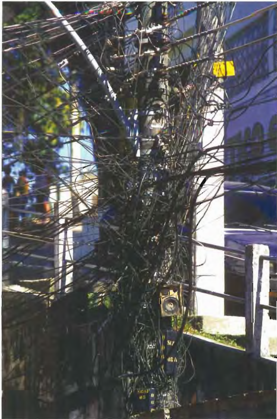
Infraestructura Rocinha, Brasil 2003
